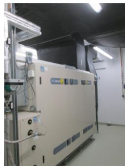
*Be- und Entlüftungsgerät für Halle und Sanitärtrakt mit Wärmerückgewinnung*
