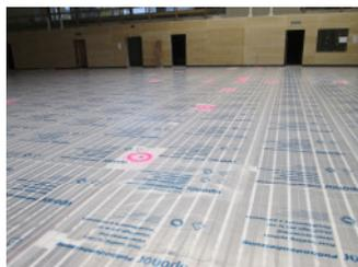
*1350 m<sup>2</sup> Sportbodenheizung als Trockenverlegesystem*
