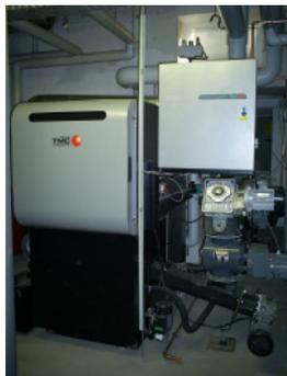
*Fröling Pelletkessel 100 kW*
