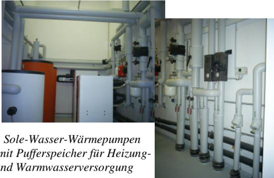
2 Sole-Wasser-Wärmepumpen mit Pufferspeicher für Heizung- und Warmwasserversorgung
