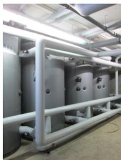
Pufferspeicher 4 x 500 l für Trinkwassererwärmung
