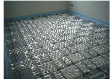
Fußbodenheizsystem mit Pyramidenwärmeleitblechen für Niedertemperatursystem
